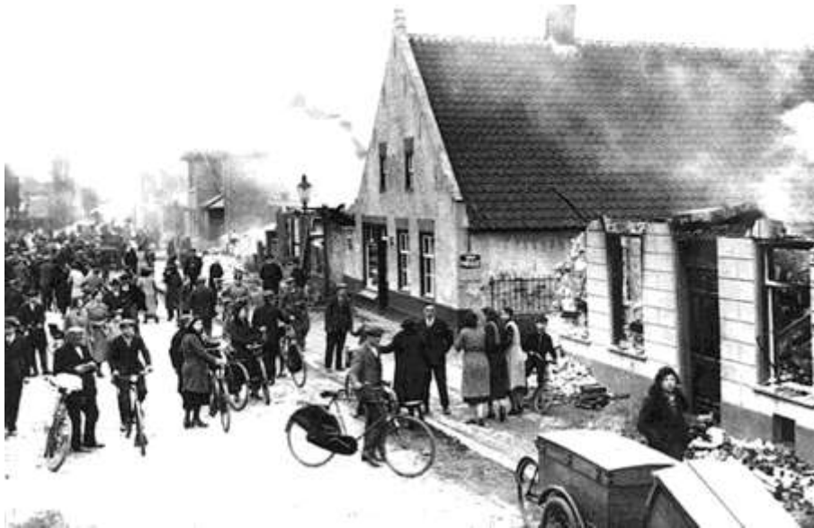
Honderd jaren later (1934) was er weer een grote brand aan het Hoogeinde. Publieke belangstelling na de brand, ter hoogte van de nrs. 12- 22b, waarbij 5 woningen, enkele schuren en de schoenfabriek van de fa. Vermeer afbrandden. Foto gezien naar het oosten. Bron: SALHA WAA20315
